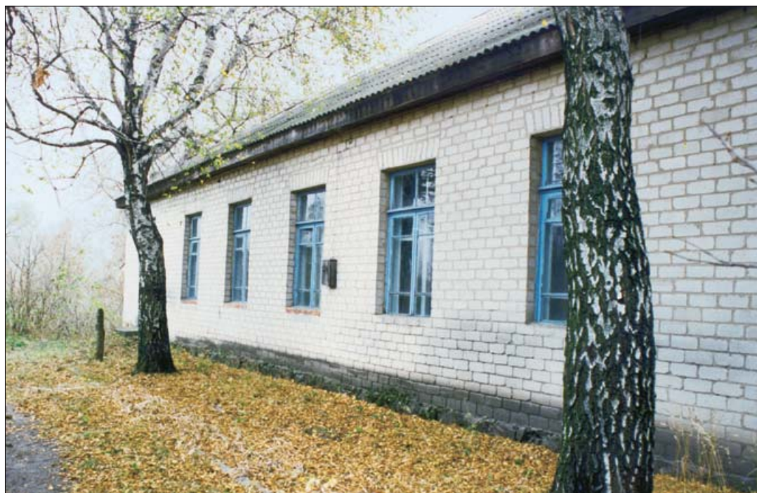
Здание бывшей школы в с. Низших Верещаках
